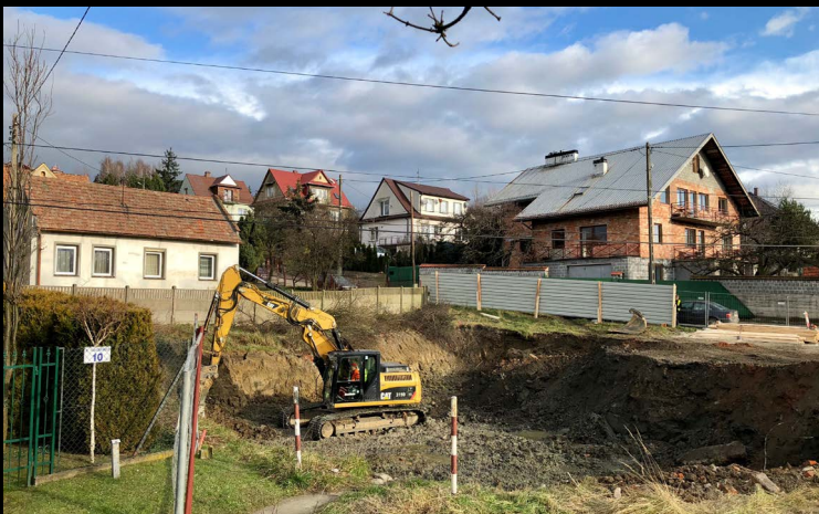
Budowa nowego muzeum ruszyła w grudniu 2017 r. na jedenaście miesięcy przed setną rocznicą odzyskania przez Polskę niepodległości.
