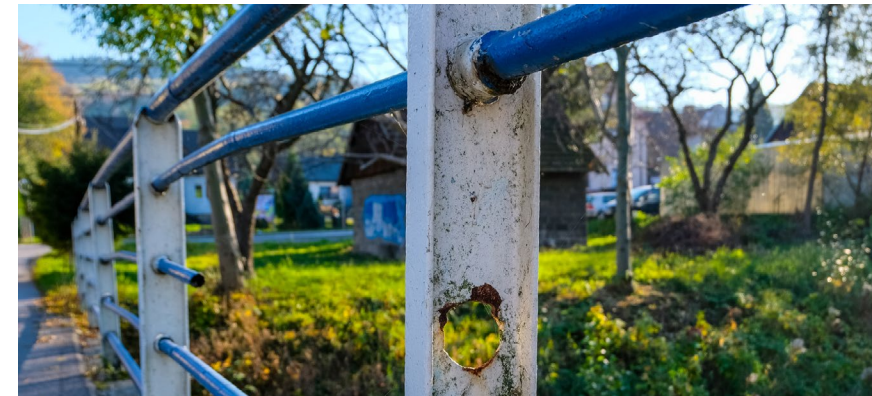
W jednej z poręczy brakuje wsporników, a elementy trawi rdza.
